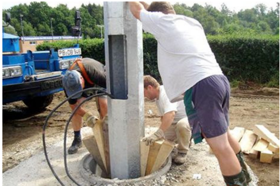
Das Fundament hat die Ausmaße von 2 mal 2 mal 2 Metern. Bild: IBR-Flutlicht
