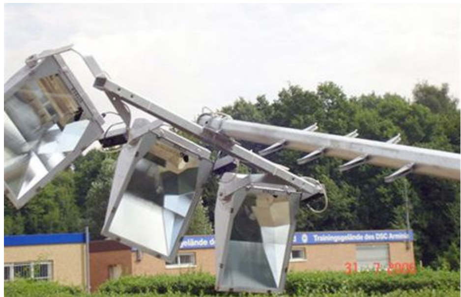
An jedem Mast sind drei Strahler angebracht. Bild: IBR-Flutlicht
