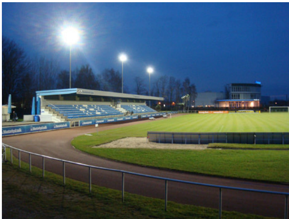
Die neue Beleuchtungsanlage in Holzwickede verfügt über eine mittlere Beleuchtungsstärke von 310 Lux.
