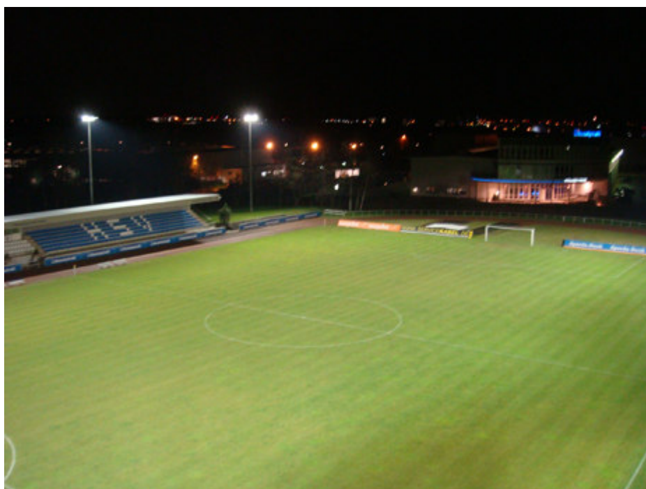
Durch regelmäßige Wartung der Masten lässt sich langfristig gesehen bares Geld sparen.
