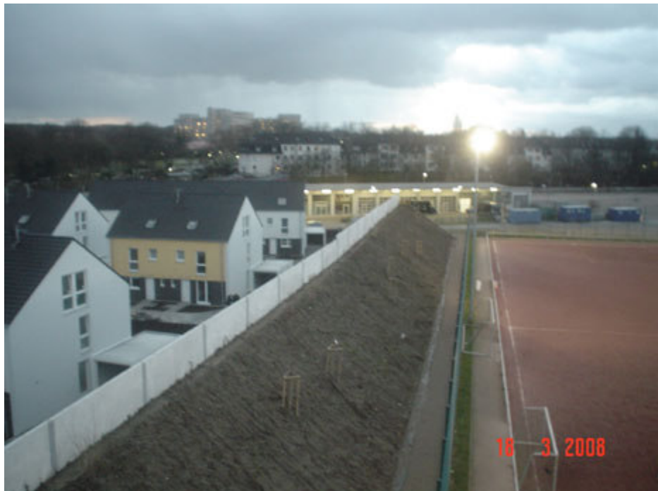
Dank der Installation der Blendungsbegrenzer ist das Wohngebiet nun vor „schädlicher Blendung“ geschützt.
