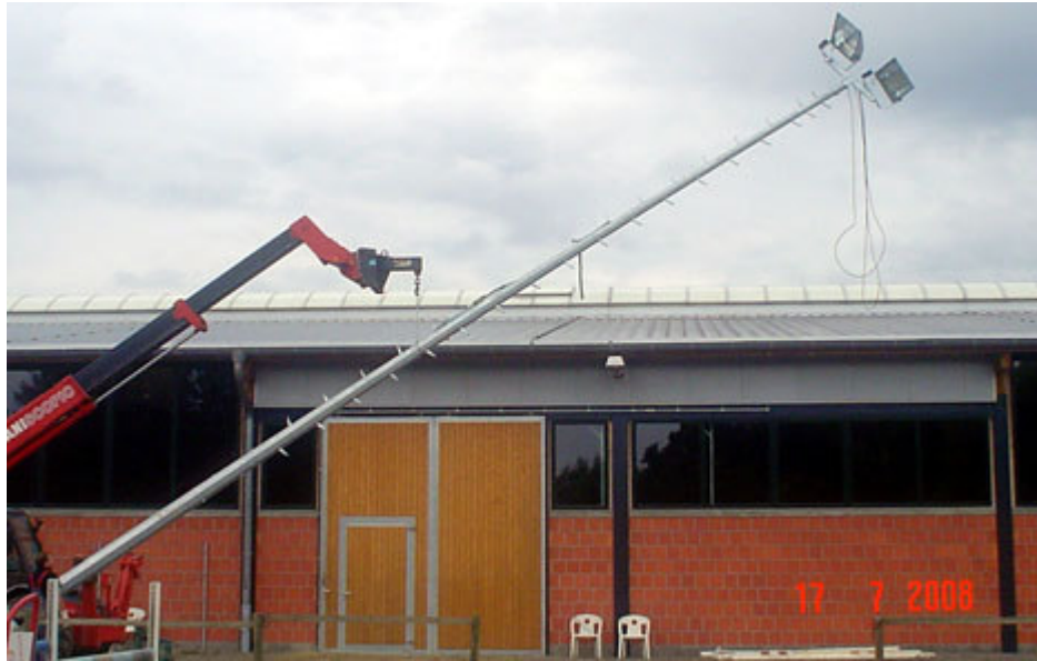
Unter Einsatz von schwerem Gerät wurden die Maste in die Vertikale gebracht.
