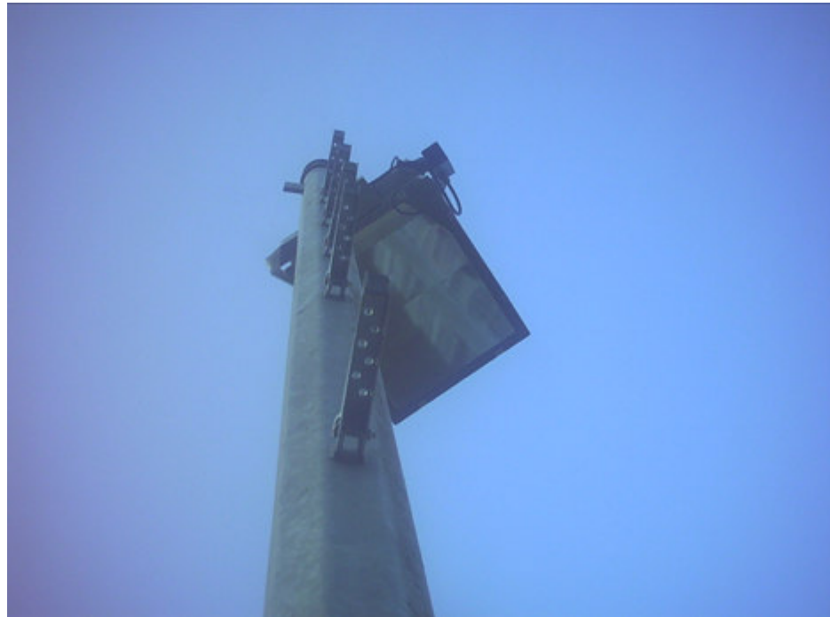
Einer der neuen Flutlichtmasten Alle Bilder: IBR-Flutlicht
