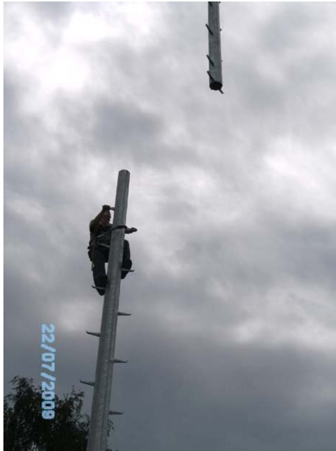
Besteigung eines Flutlichtmastes Bilder: IBR-Flutlicht GmbH
