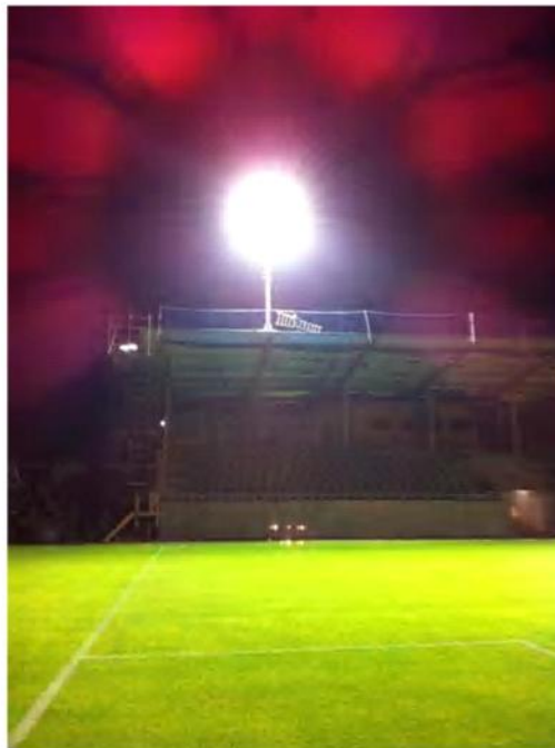
Einige Sondermasten wurden mittels Flanschplatte auf die Tribüne montiert
