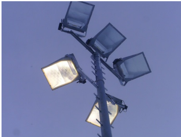
Das Ingenieur-Büro Rößler hat fünf Flutlichtanlagen in Braunschweig saniert oder neu errichtet
