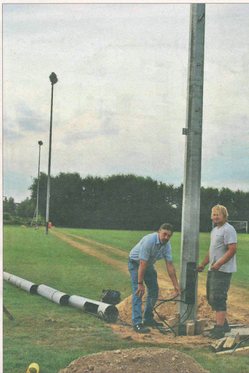
Oskar Lütjhe (links) und Anlagenmonteur Matthias Blesse arbeiten am neuen Flutlichtmast auf dem Sportplatz in Weetzen. Siegmund
